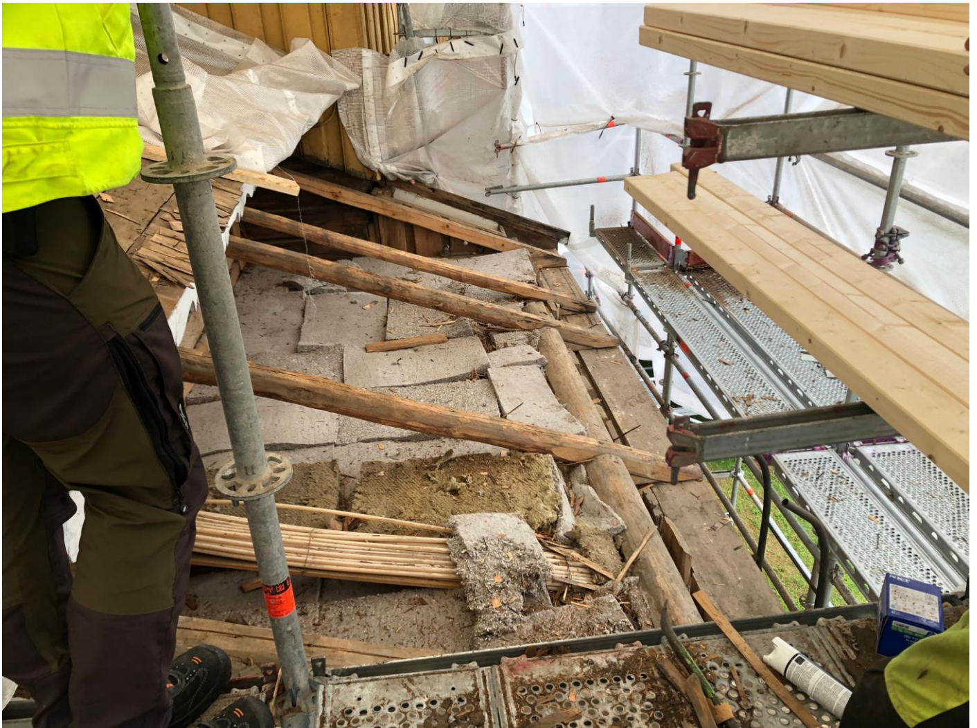
Sakastin laajennuksen katto on vuotanut pitkään laajennusosan kohdalta.
